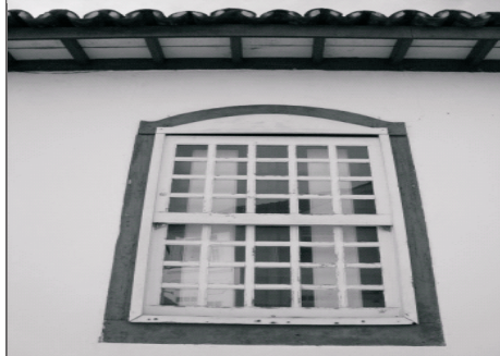
Rua Direita/ Casa Nº 13
