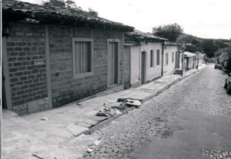
Rua Santa Cruz – Vista Parcial, Sentido Leste-Oeste
