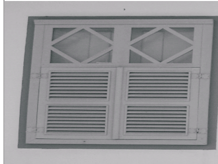
Rua Direita/ Casa Nº 55
