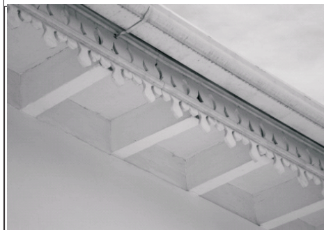
Rua Direita/ Casa Nº 17
