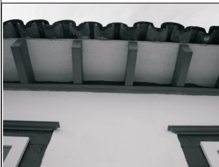
Rua Direita/ Casa Nº 07
